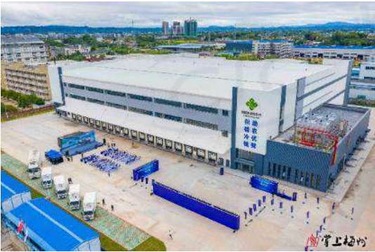
广东供销天兴冷链物流中心—梅州首个冷链物流项目，库容3万吨、总投资1.5亿元
